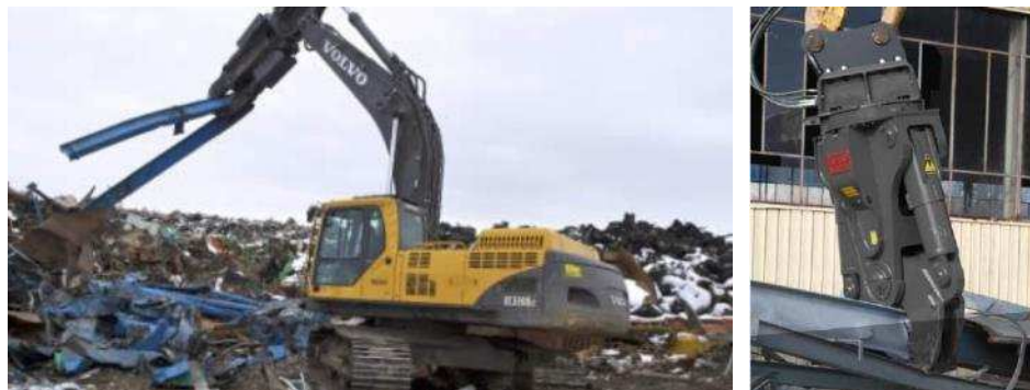
Figure 2 : Exemple de travaux de démolition de structures
