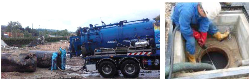
Figure 3 : Exemple de travaux de nettoyage/dégazage de cuve
