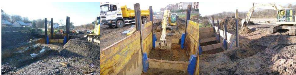
Figure 4 : Exemple de travaux de dépollution avec terrassement dans les blindages
